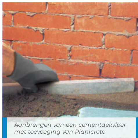
Aanbrengen van een aanbrandlaag met toevoeging van Planicrete
