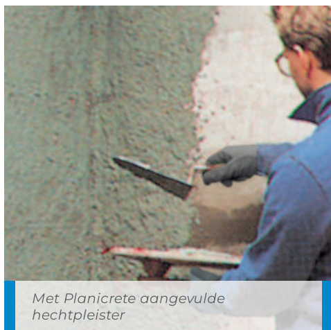
Aanbrengen van een aanbrandlaag met toevoeging van Planicrete
