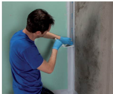
Aanbrengen van Mapeband PE 120 met Mapegum WPS
