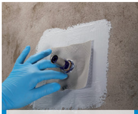
Aanbrengen van een Mapeband PE 120 afdichting voor doorlopende gaten met Mapegum WPS
