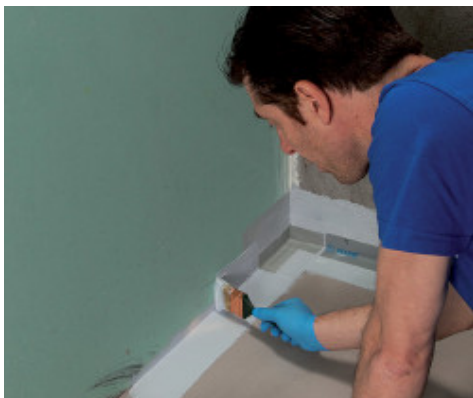
Aanbrengen van Mapeband PE 120 met Mapegum WPS
