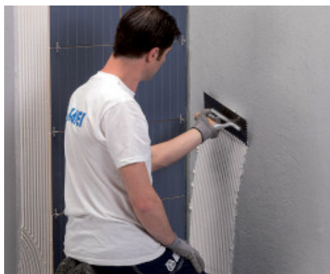
Aanbrengen van wandbekleding met Keraflex Maxi S1
