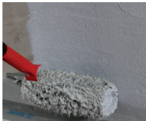
Aanbrengen van Mapegum WPS met een roller
