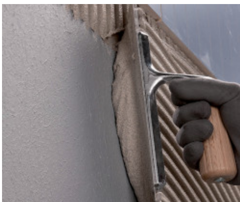
Aanbrengen van vloerbedekking met Ultramastic 5
