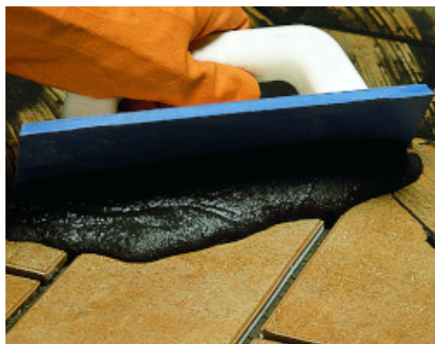
Voegen van een klinkervloer buiten met Keracolor GG aangemaakt met Fugolastic
