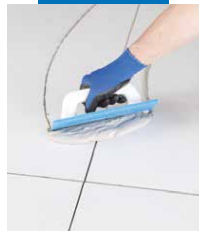
Verspreiden van Ultracolor Plus op porseleinen vloertegels met een rubberen spaan
