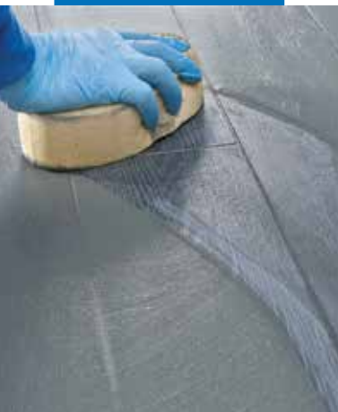
Reinigen en afwerken van voegen met een harde cellulose spons
