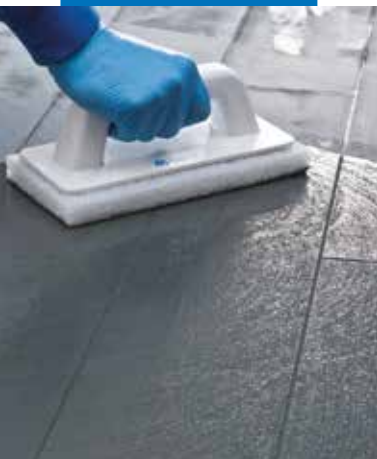
Reinigen van de voegen met een Scotch-Brite® spons (wanneer het product half is uitgehard)
