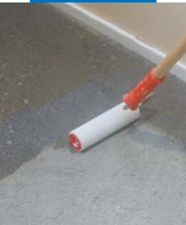
Primer G aanbrengen met een roller
