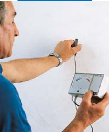
Metten van het vochtgehalte van het gips
