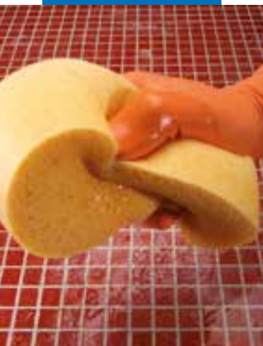
Natmaken van het afgevoegde oppervlak voorafgaand aan de reiniging
