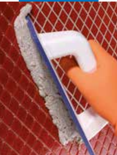
Aanbrengen van Kerapoxy Design
