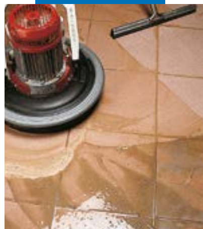
Gebruik van een rubber vloertrekker, inwas- en uitpoetsmachine bij het afwerken van een gresvloer
