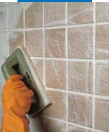
Afwerken van enkelgebakken tegels met ScotchBrite®
