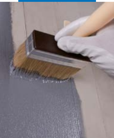
Met een kwast aanbrengen van Eco Prim Grip Plus op beton
