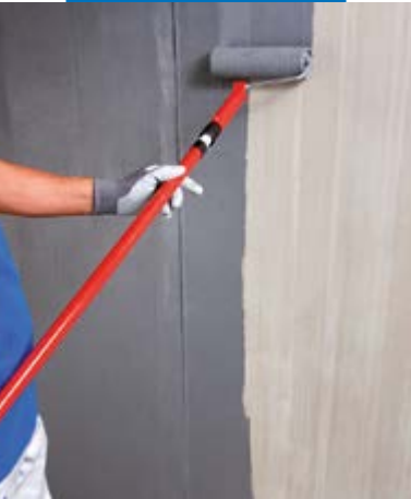
Met een rol aanbrengen van Eco Prim Grip Plus op beton
