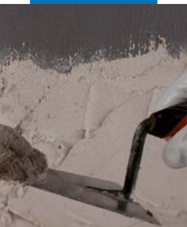
Aanbrengen van pleisterwerk op Eco Prim Grip Plus
